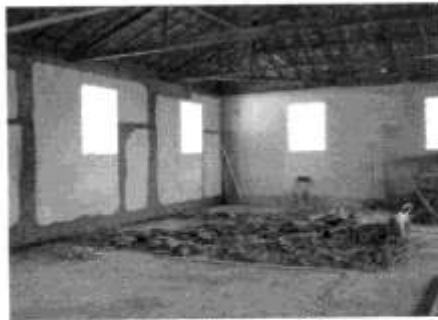
Construção - Tatame - Chácara
