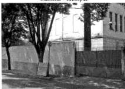
Muro Externo - Kemper
