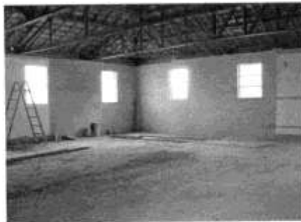
Construção - Sala de espelhos - Chácara
