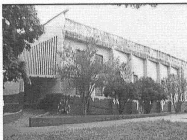
Auditório – Vista Externa
