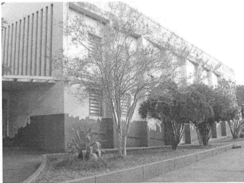
Auditório – Vista externa
