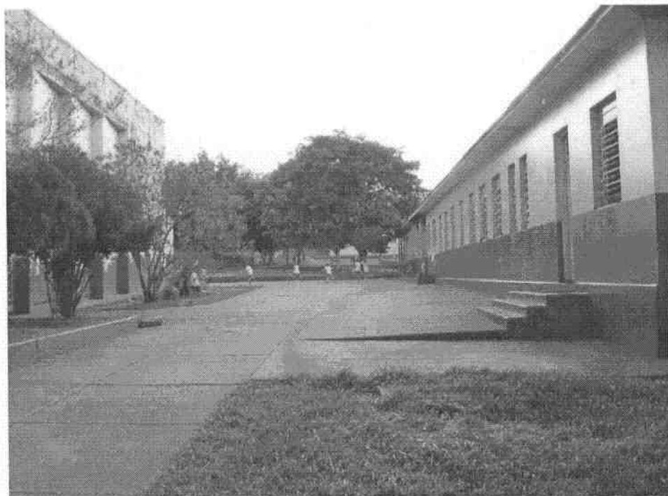
Primário/Auditório – vista externa
