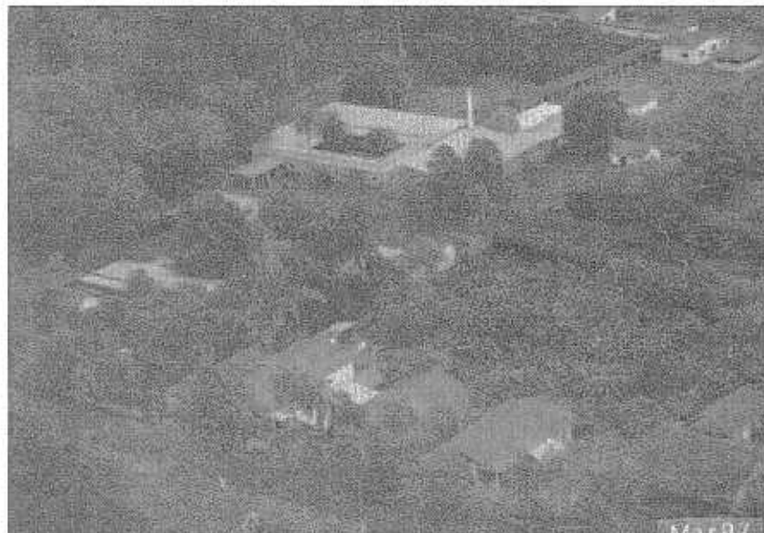
Hospital de Clínica Geral
