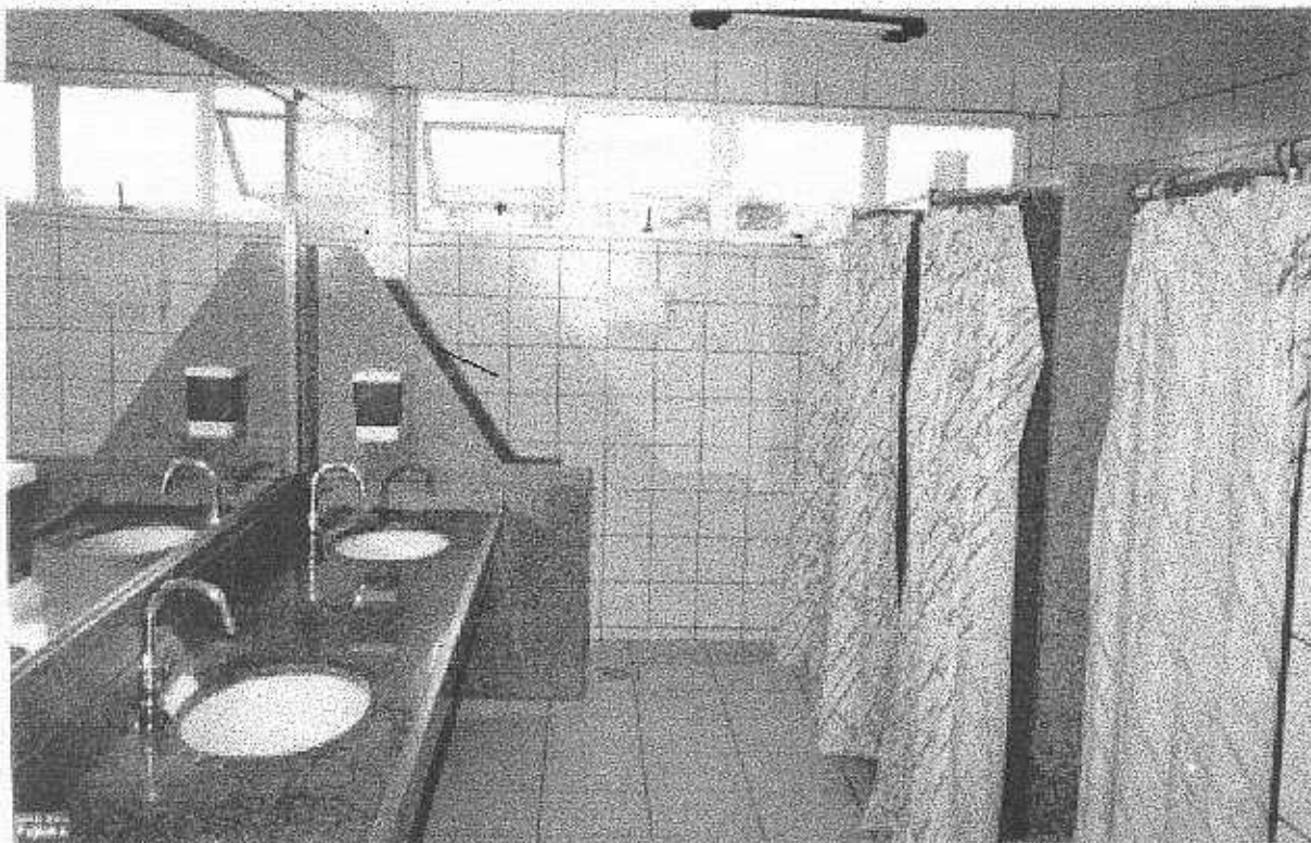
Sanitário Masc. e Fem. - Ausência de portas. Em cada box utiliza-se cortinas.
