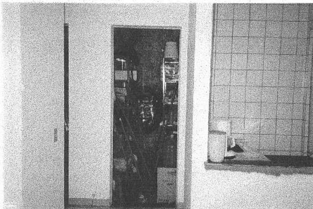
Sanitário inacabado - Utilizado como depósito.
