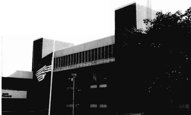
FIGURA 26 - Vista parcial da escola Lew-porter .
