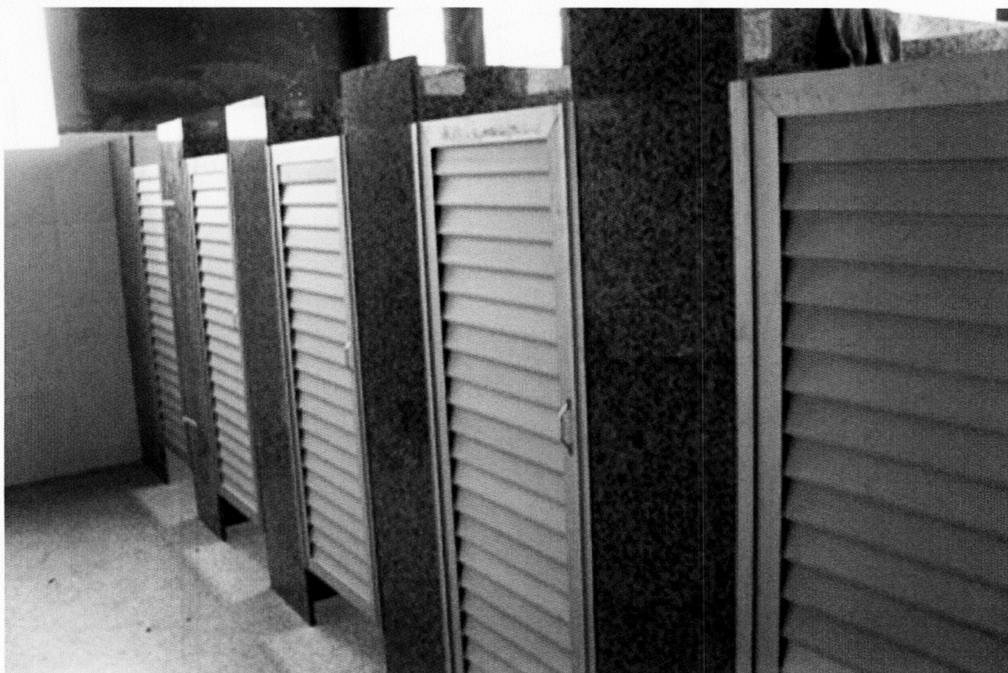
Colocação de porta no banheiro dos alunos.
