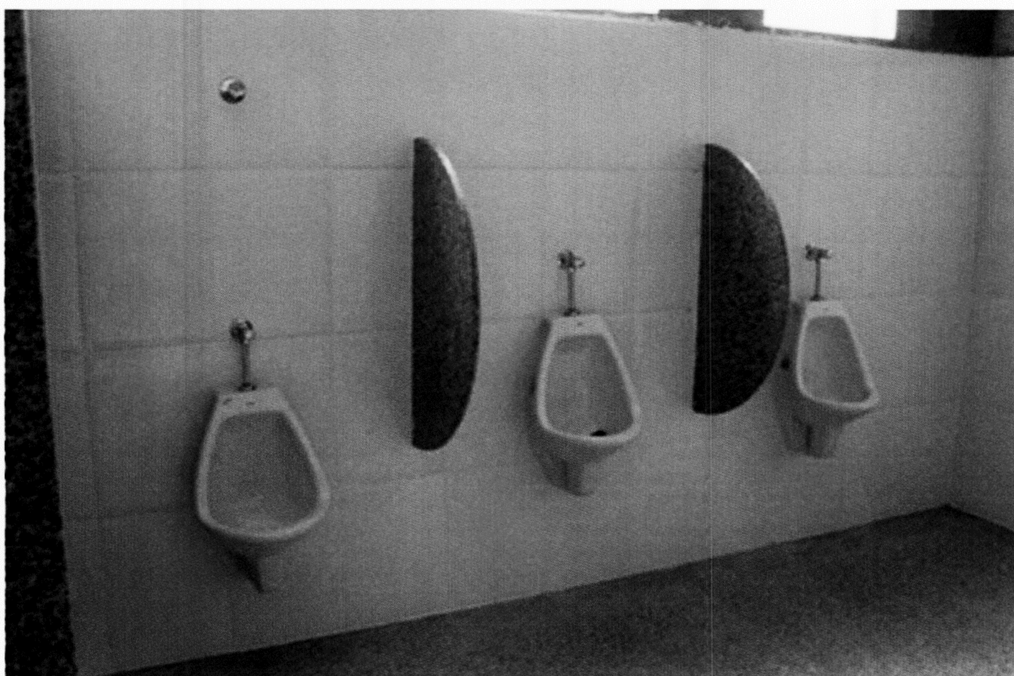
Banheiro dos alunos em fase de acabamento.
