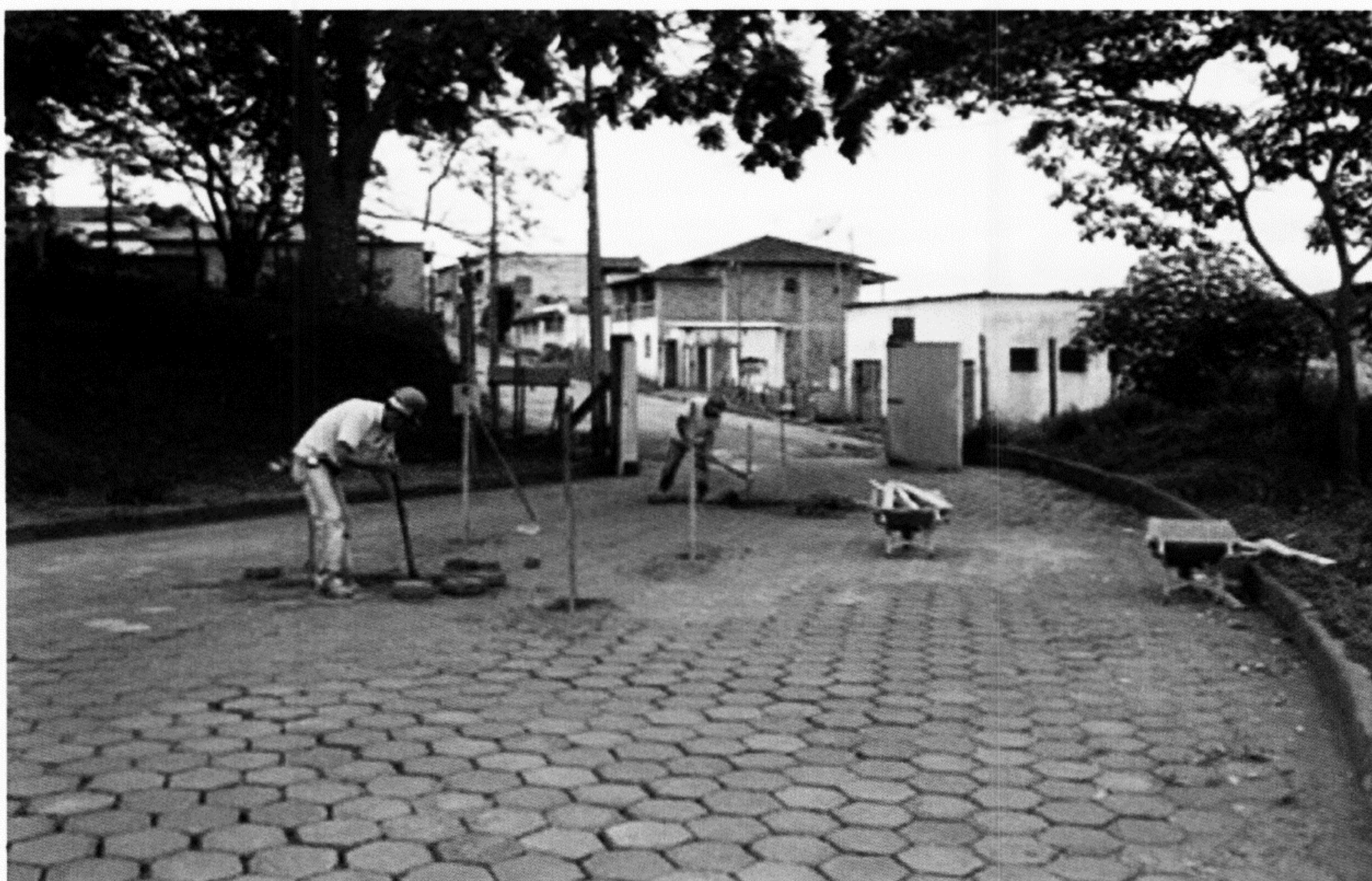
Início das obras para construção da guarita de porteiros.
