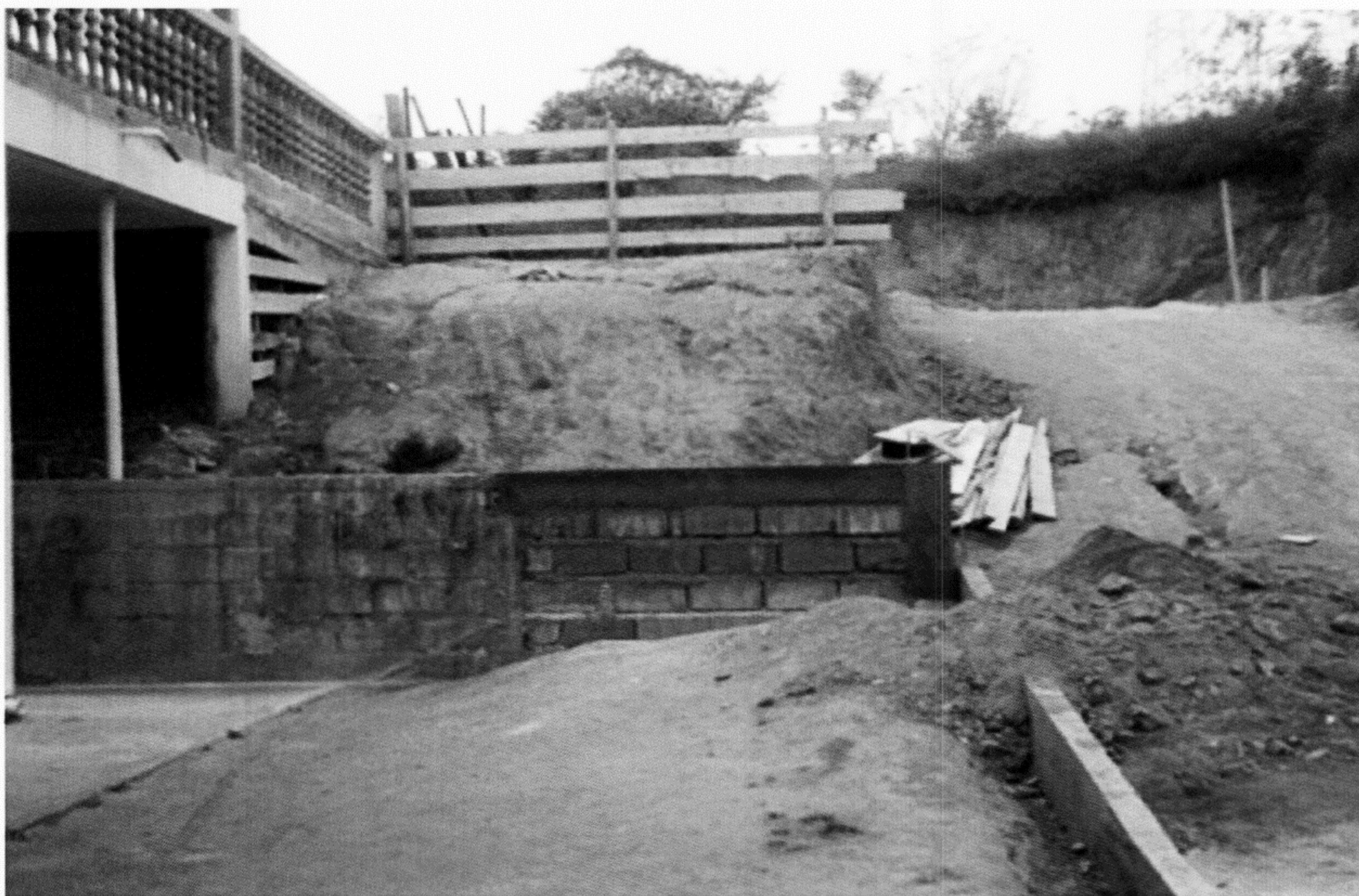
Preparação da área de acesso às quadras para colocação de bloquetes e grama.
