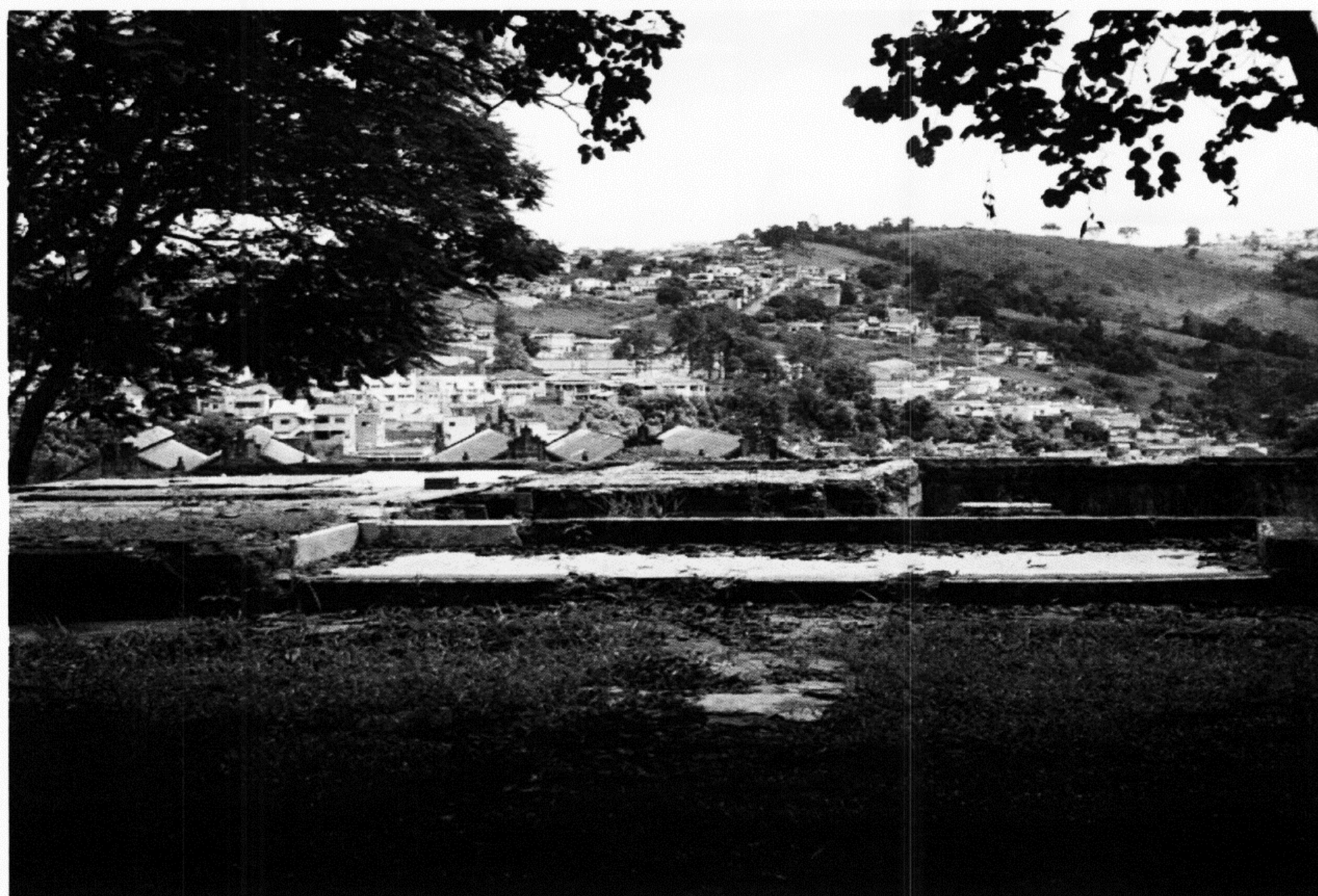
Casa da Curva: paredes sem sustentação são demolidas para dar lugar a uma estrutura com maior segurança.
