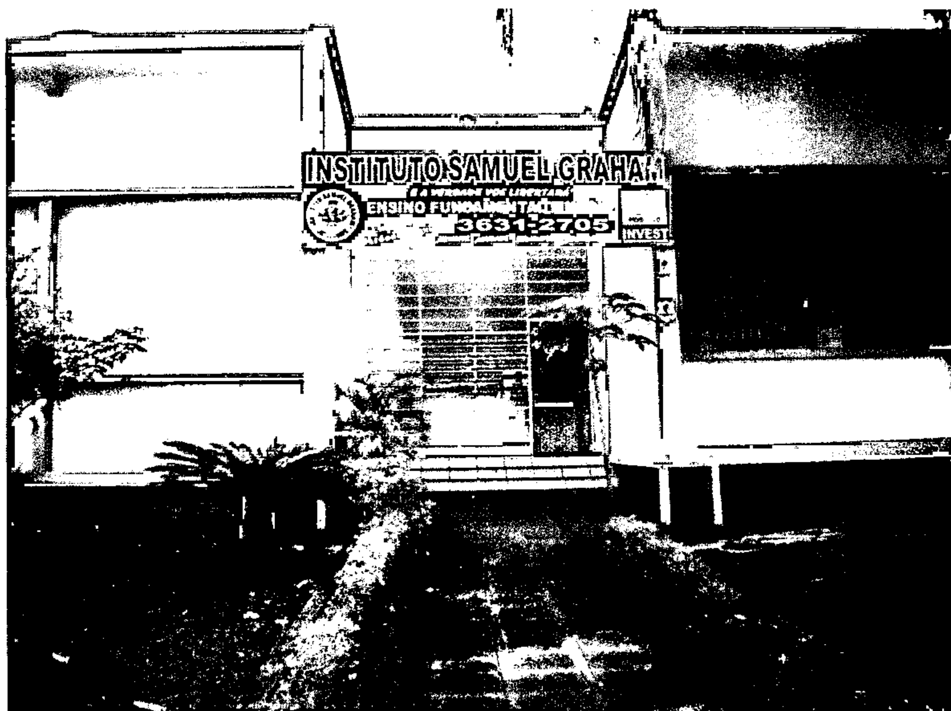
Foto 01 - Prédio do administrativo.
